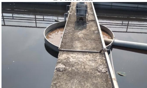
Bể lắng thứ cấp
